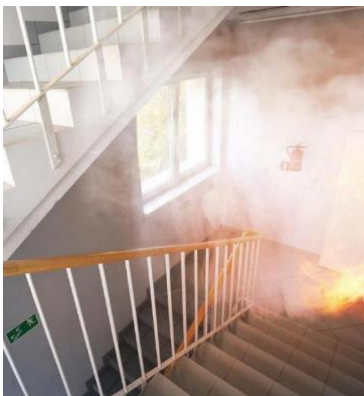
Slika 20. Požar u stubištu
