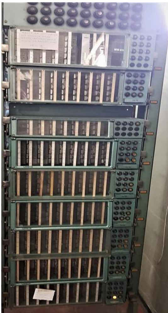
Slika 2. Stalak za velike relejne grupe [24]
