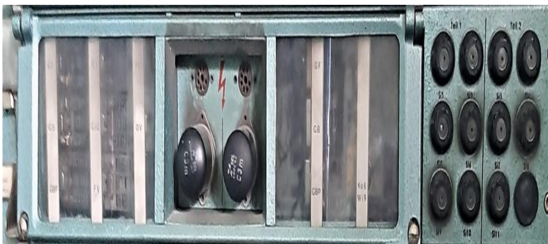
Slika 3. Kolosječna relejna grupa [24]
