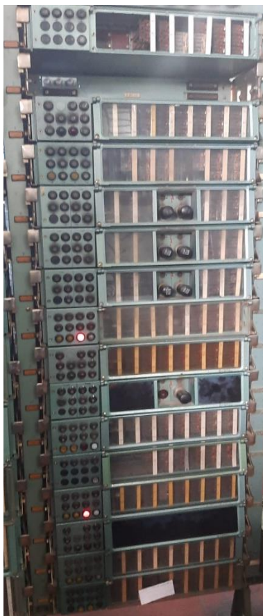
Slika 1. Stalak za male relejne grupe [24]
