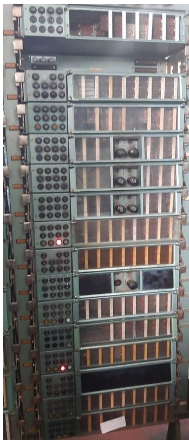
Slika 1. Stalak za male relejne grupe [24]
