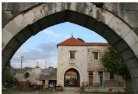
Slika 15. DETALJ IZ UNUTRAŠNJEG DVORIŠTA MAŠKOVIĆA HANA
