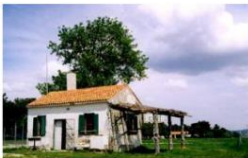
Slika 16. NADZORNA KUĆICA NA CRKVINAMA
