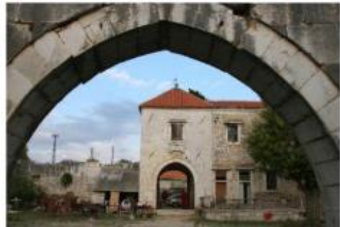
Slika 15. DETALJ IZ UNUTRAŠNJEG DVORIŠTA MAŠKOVIĆA HANA
