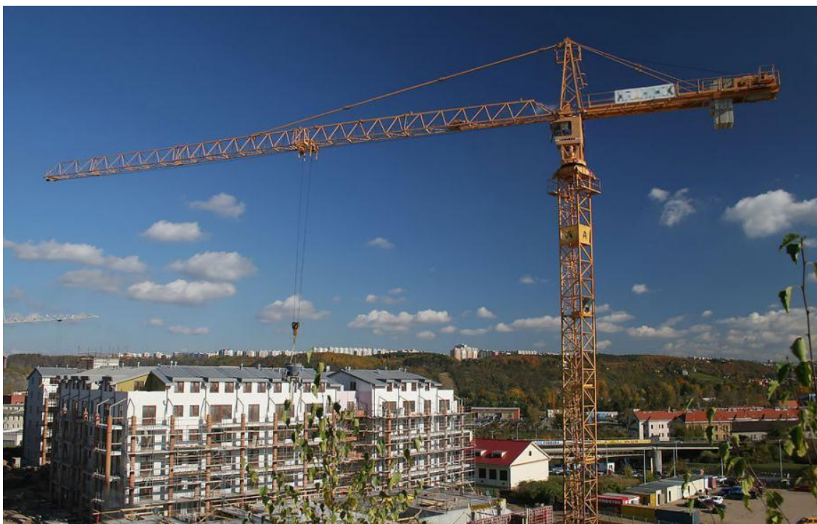
Slika 12. Kran koji svojom veličinom pokriva cijelo gradilište
