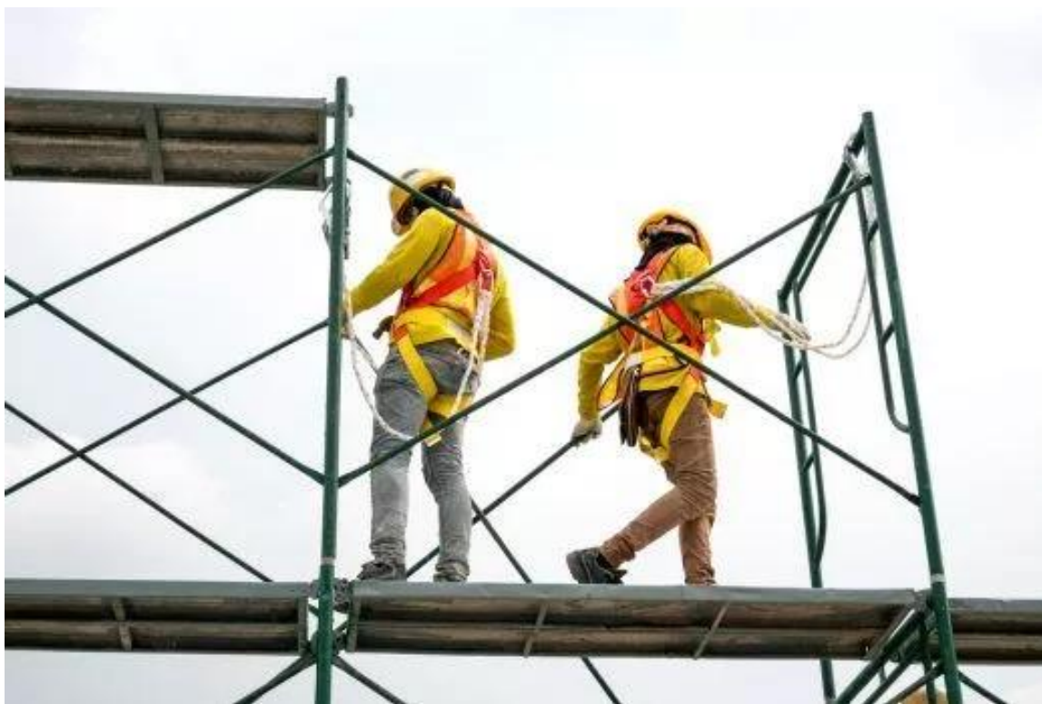
Slika 14. Radnici na skeli sa zaštitnim pojasom
