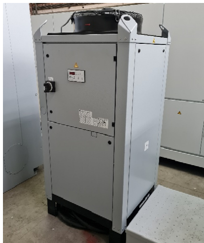
Slika 14. Izgled rashladnog agregata
