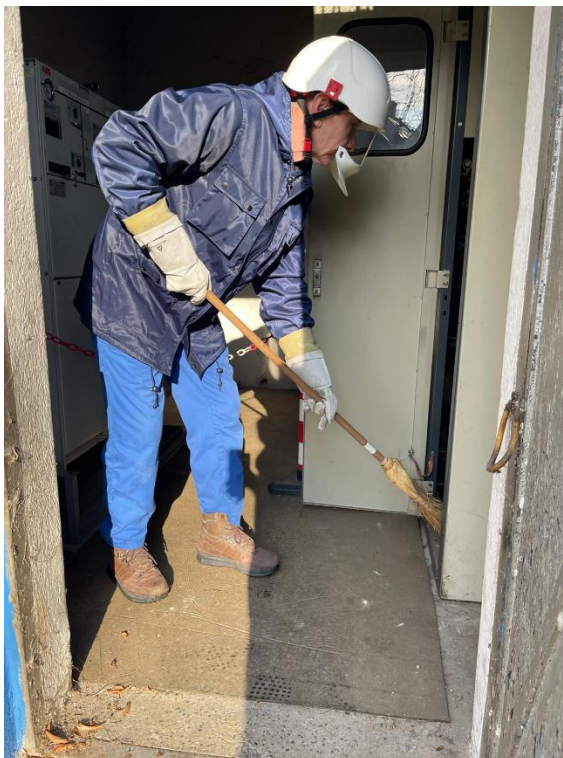
Slika 32. Čišćenje dijela trafostanice [Vlastiti izvor]
