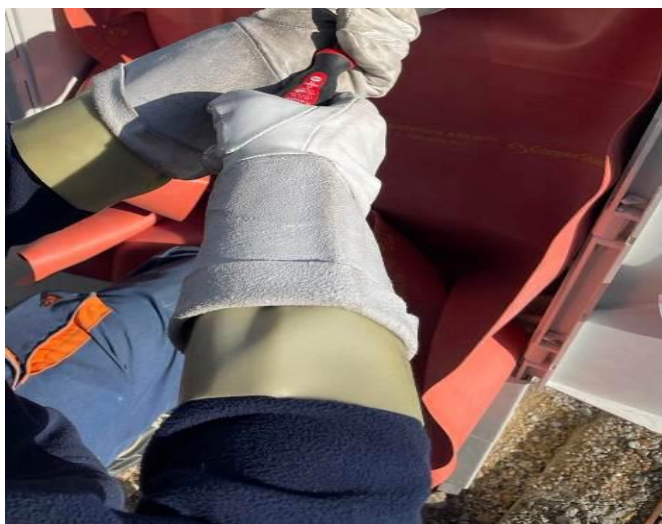
Slika 5. Pravilno korištenje zaštitnih rukavica (izolacijske rukavice s nadrukavicama) [Vlastiti izvor]
