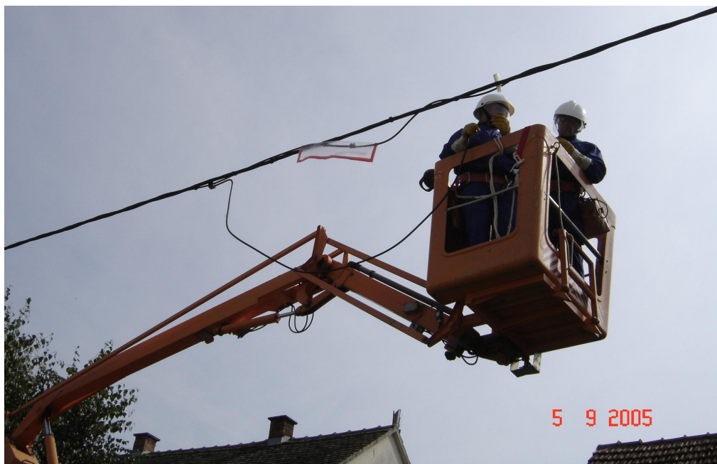
Slika 21. Postavljanje premosnice [Vlastiti izvor]
