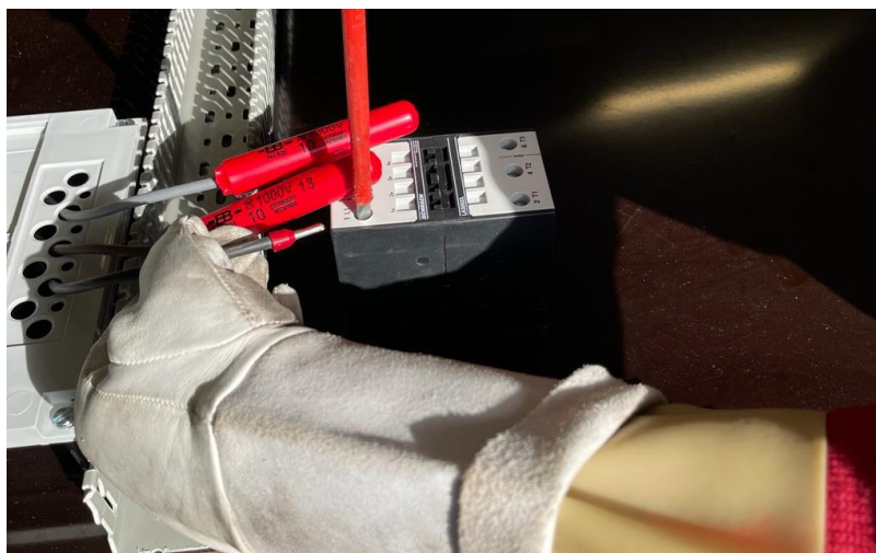
Slika 31. Spajanje priključnih vodiča na sklopnik [Vlastiti izvor]
