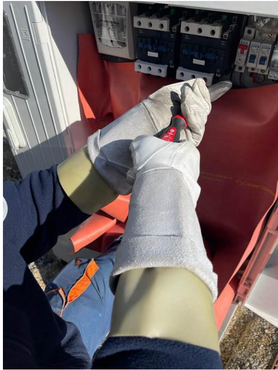
Slika 28. Zamjena sklopnika u upravljačkom ormaru javne rasvjete [Vlastiti izvor]
