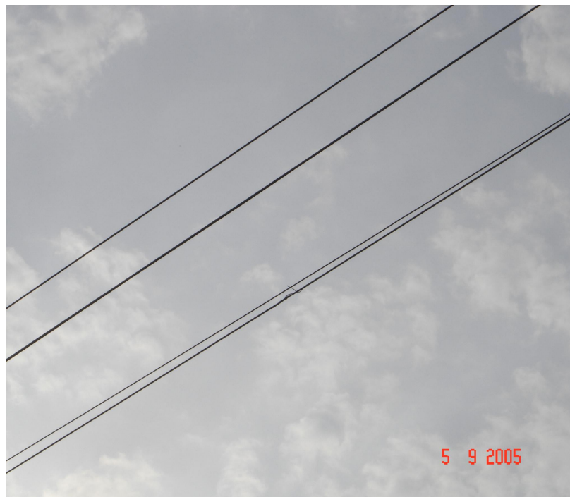
Slika 16. Primjer oštećenog vodiča [Vlastiti izvor]
