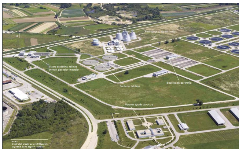
Slika 4. Centralni uređaj za pročišćavanje otpadnih voda grada Zagreba [8]
