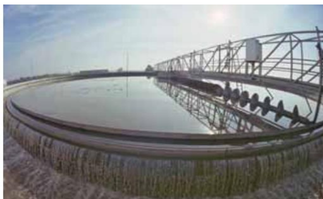
Slika 13. Prehodni taložnik [11]
