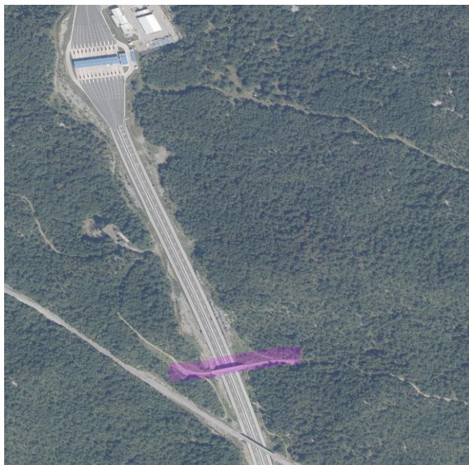
Slika 25. Orto-foto snimka sa ljubičastom bojom označenim prijelazom Rupa naplatne kućice (Izvor: www.preglednik.arkod.hr )
