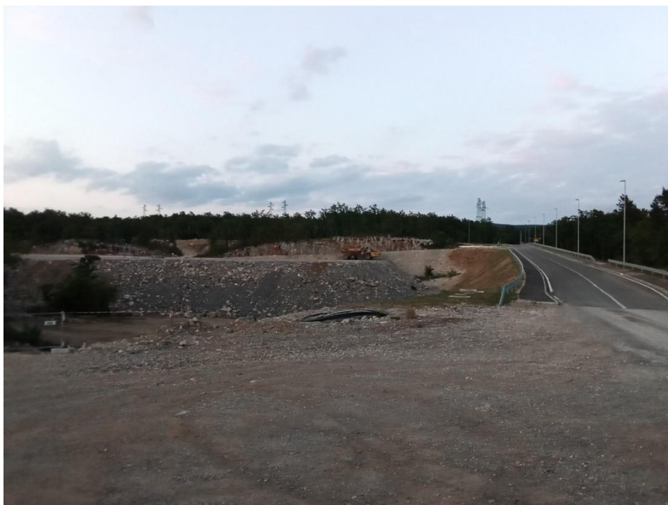
Slika 24. Industrijska zona „Brgud“
