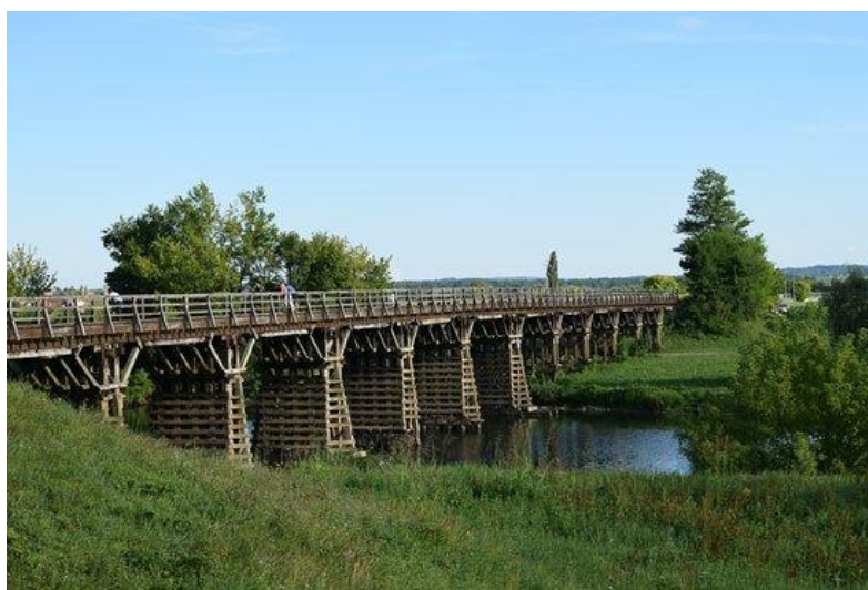
Slika 11. Drveni most u Karlovcu
