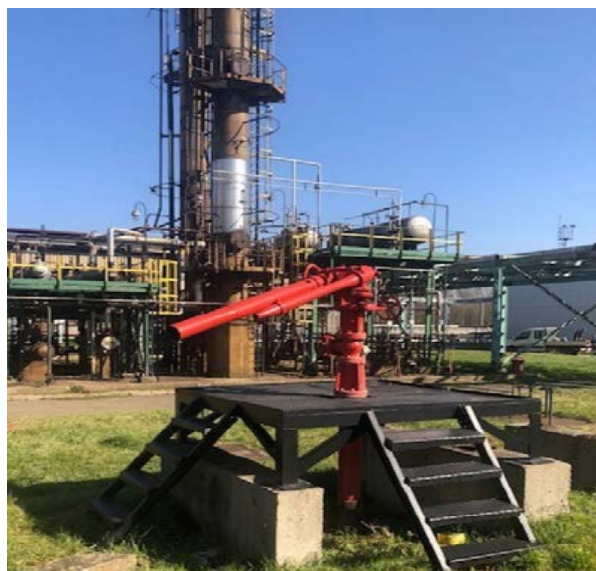
Slika 16. Stabilni bacači voda/pjena na KP-5.[5]
