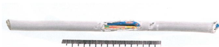
Slika 5. Prikaz mehaničkog oštećenja izolacijskog omotača [1]
