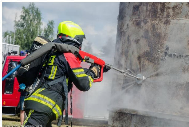
Slika 6. Rad s uređajem COBRA CCS.[4]
