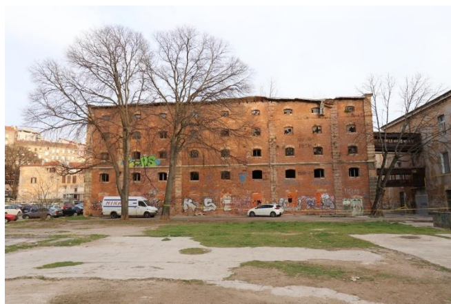
Slika 12. Ciglenu zgrada prije rekonstrukcije [24]
