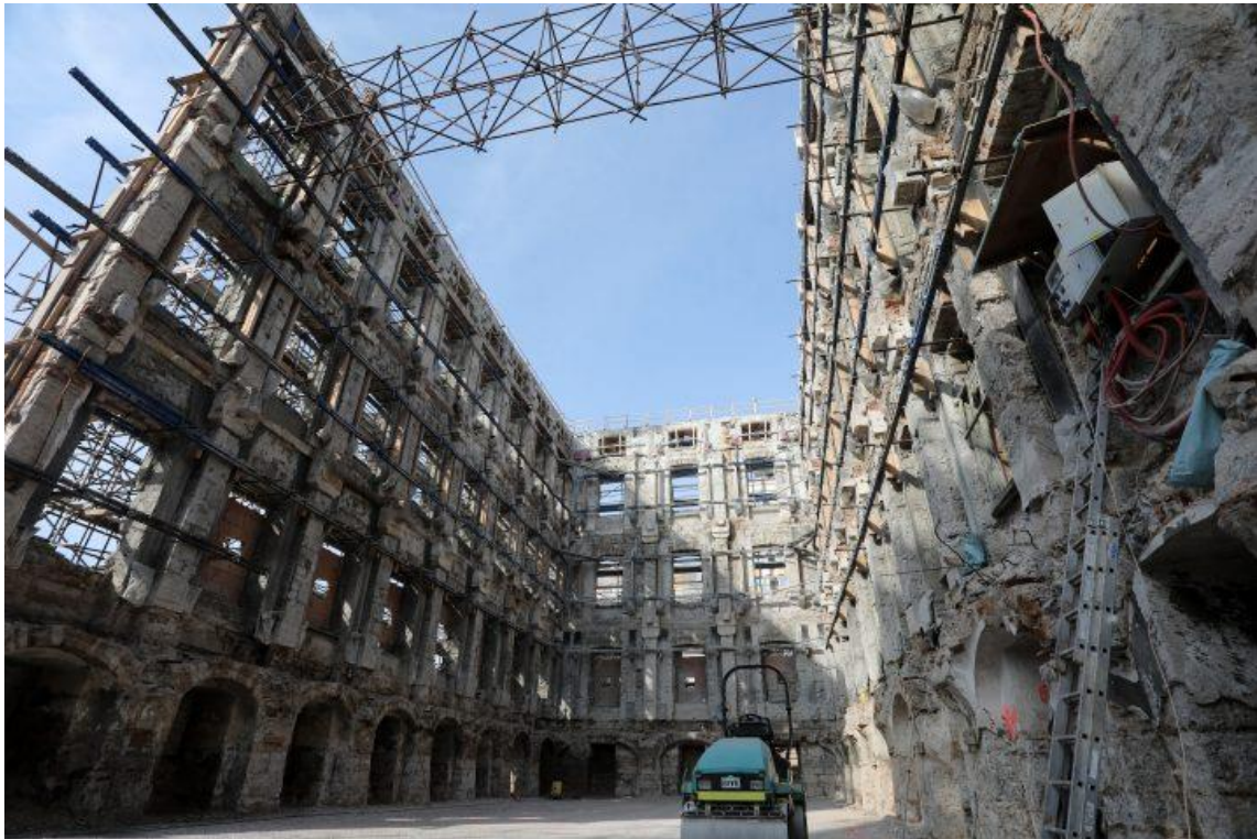
Slika 16. T-objekt tijekom rekonstrukcije [31]
