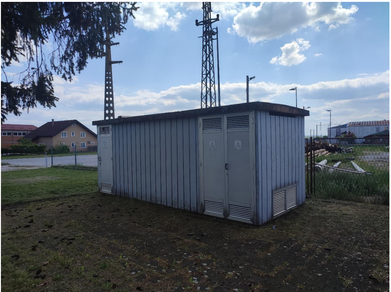
Slika 3. Trafostanica 20/04 kV
