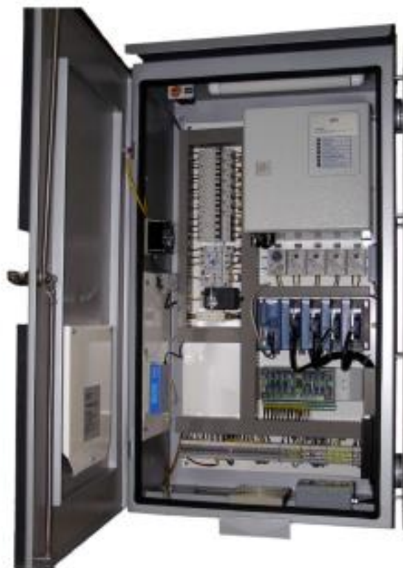
Ilustracija 9. Ormar informacijskog sustava motrenja
