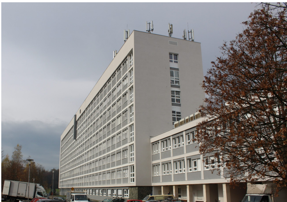
Slika 2: Opća bolnica Karlovac [6]
