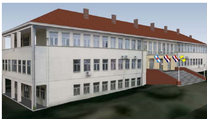
Slika 32 Ulaz u građevinu
