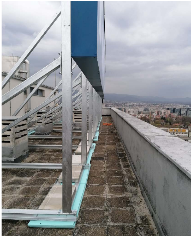
Slika 21. Spuštena reklama na krovu
