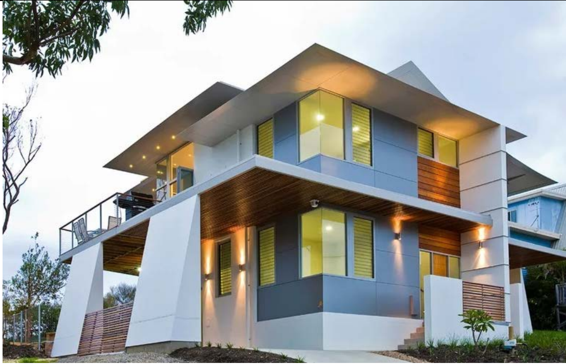
Slika 2. Primjer alucobond ventilirajuće fasade [4]
