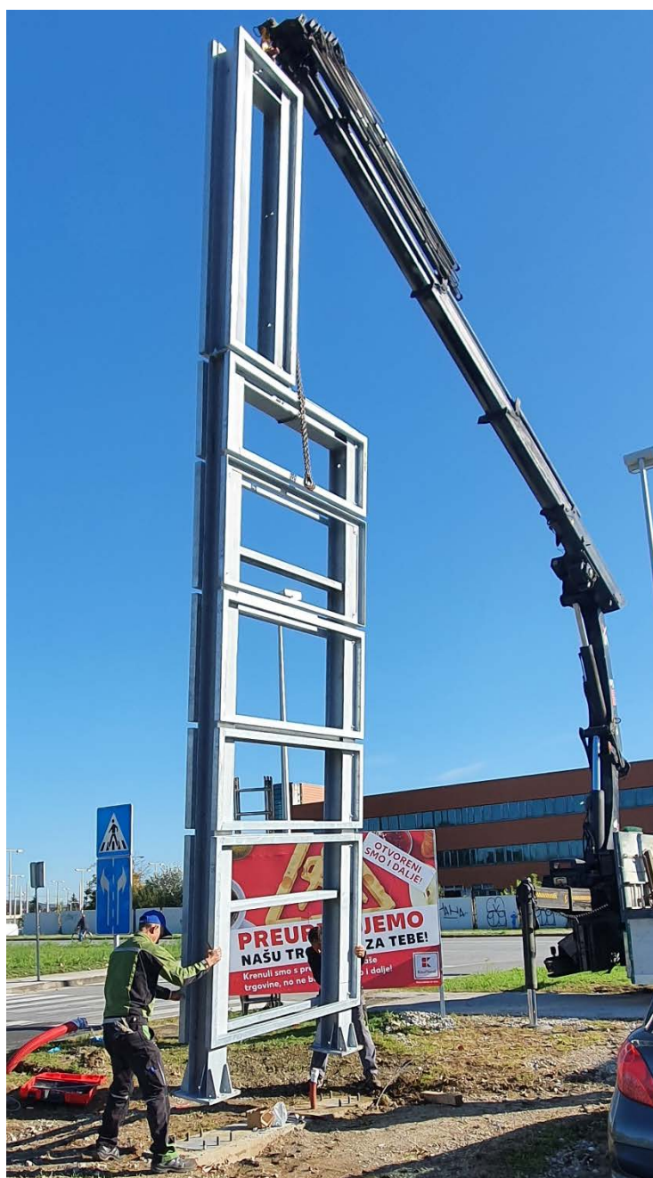
Slika 50. Dizanje konstrukcije totema
