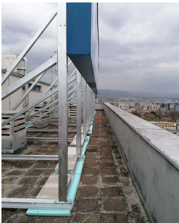
Slika 21. Spuštena reklama na krovu
