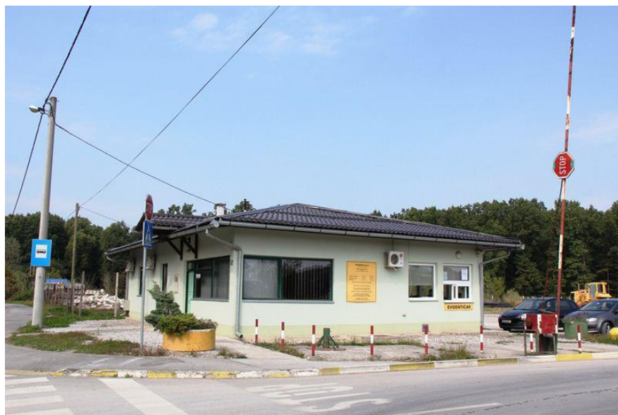
Slika 8. Upravna zgrada odlagališta.
