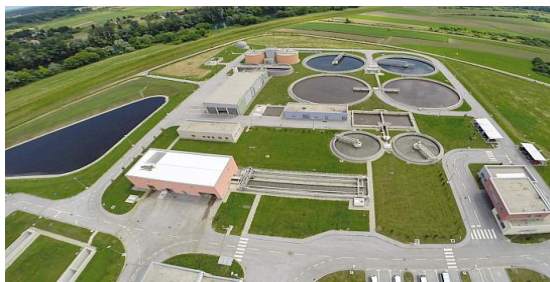
Slika 4. Uređaji za pročišćavanje otpadnih voda u Karlovcu [7]
