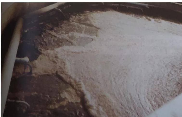
*Slika 10. Aerobna stabilizacija mulja na uređaju za pročišćavanje [8]*
