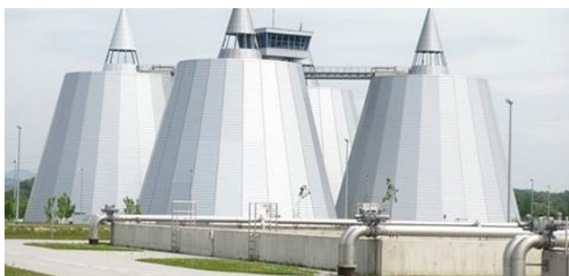
Slika 9. Tornjevi anaerobne obrade mulja na uređaju za pročišćavanje [8]
