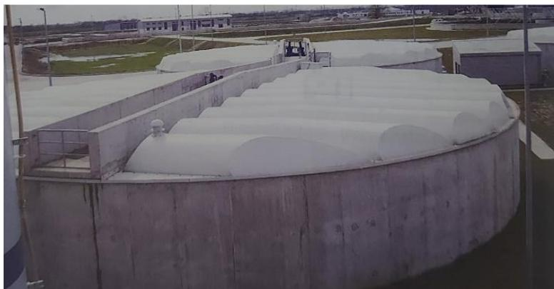
*Slika 8. Pokriveni gravitacijski zgušnjivač mulja [8]*
