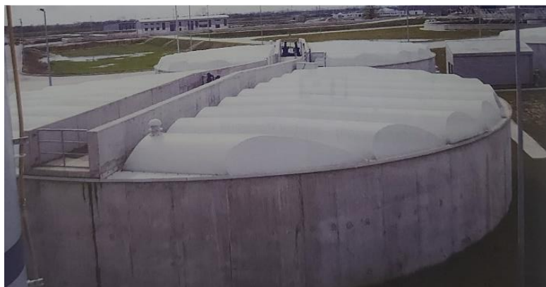
Slika 8. Pokriveni gravitacijski zgušnjivač mulja [8]
