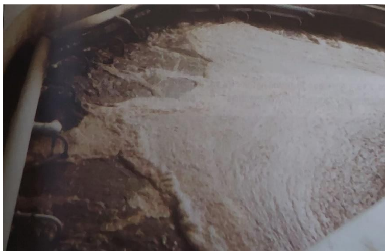
Slika 10. Aerobna stabilizacija mulja na uređaju za pročišćavanje [8]
