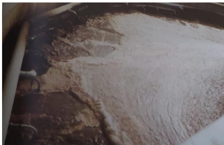
Slika 10. Aerobna stabilizacija mulja na uređaju za pročišćavanje [8]
