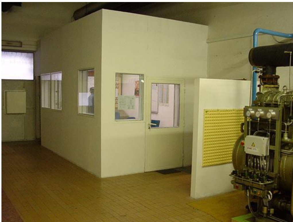
Slika 15. Primjer zvučno izolirane kontrolne sobe
