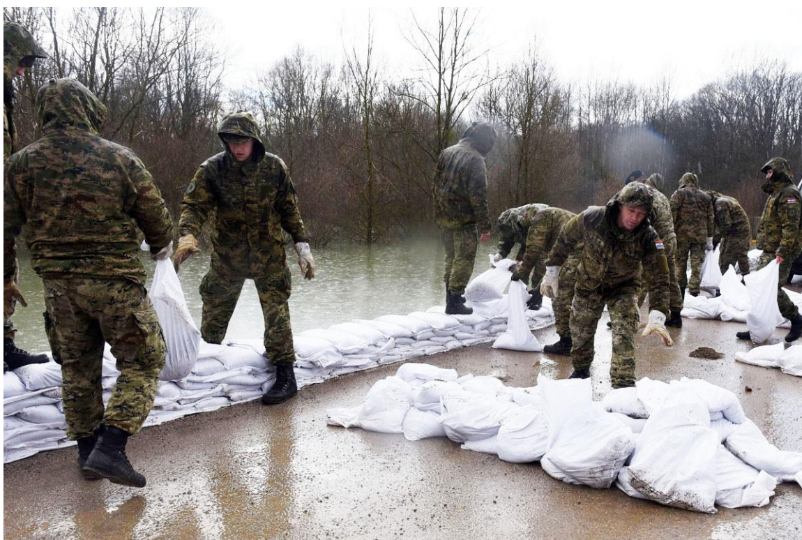
Slika 2. Izrada zečjih nasipa u svrhu sprječavanja poplave [5]
