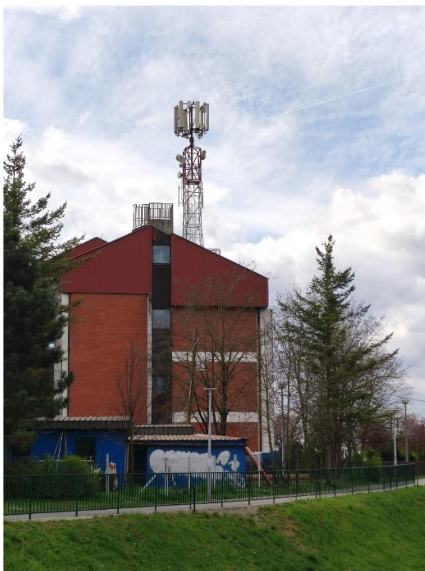
Slika 2. Antenski stup na krovu građevine
