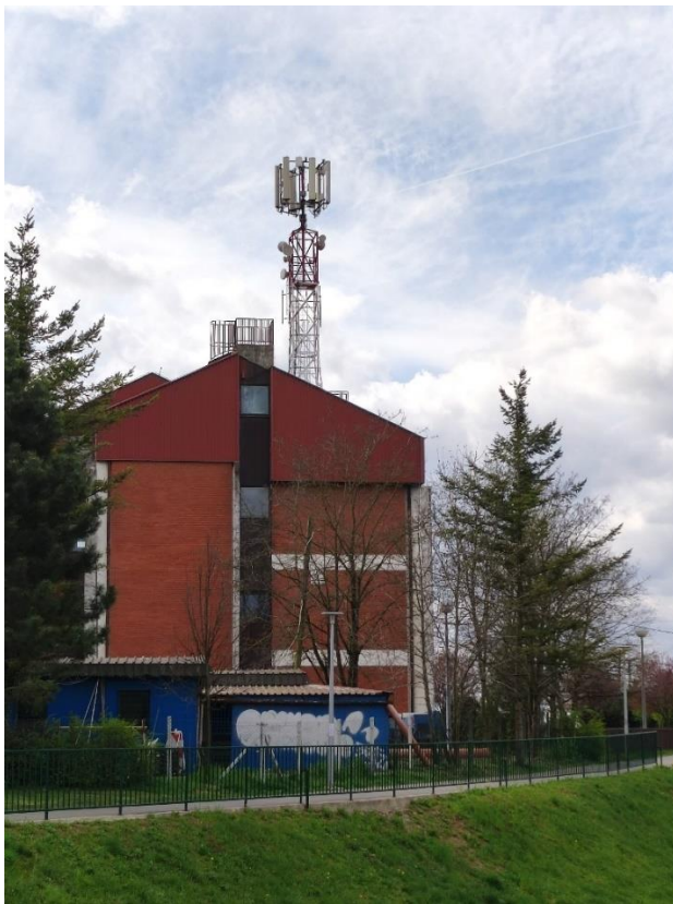
Slika 2. Antenski stup na krovu građevine
