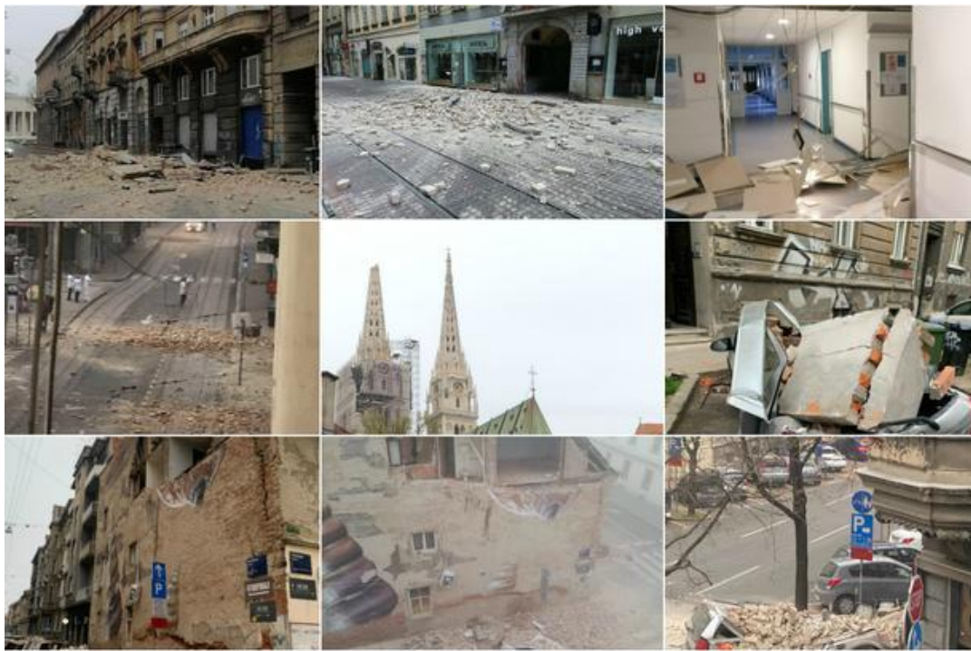
Slika 4. Materijalna šteta zagrebačkog potresa 2020. godine
