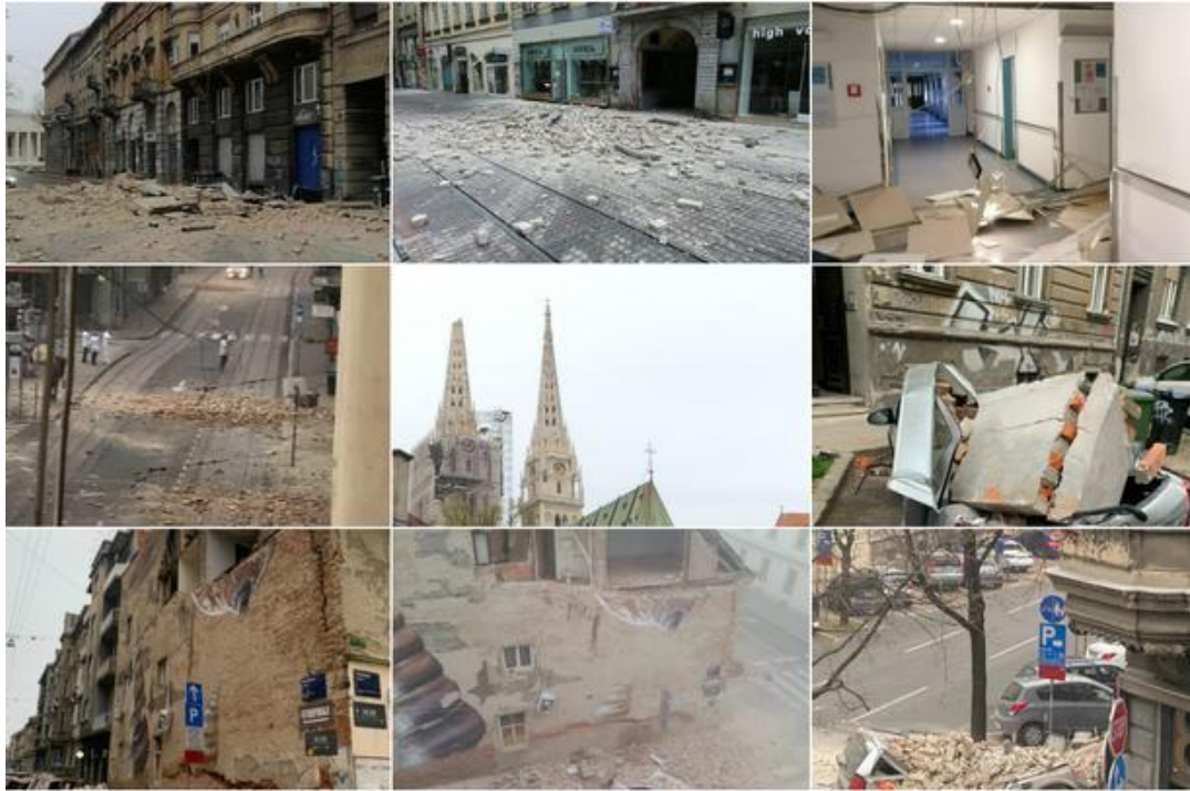
Slika 4. Materijalna šteta zagrebačkog potresa 2020. godine
