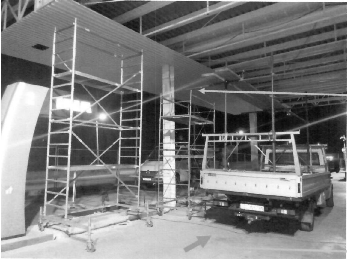
Slika 7 Incident na benzinskoj postaji [11]
