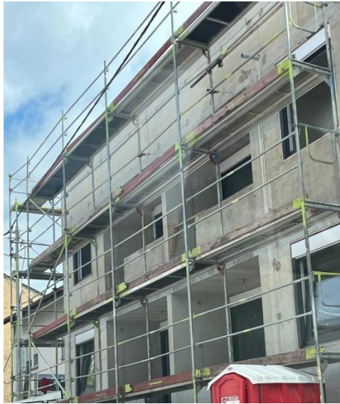
Slika 1. Izvođenje radova na građevini
