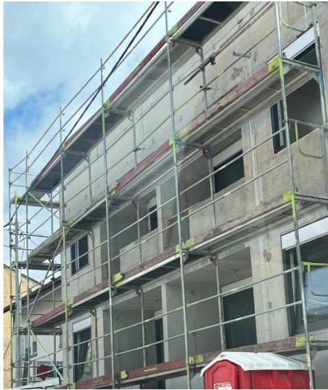
Slika 1. Izvođenje radova na građevini
