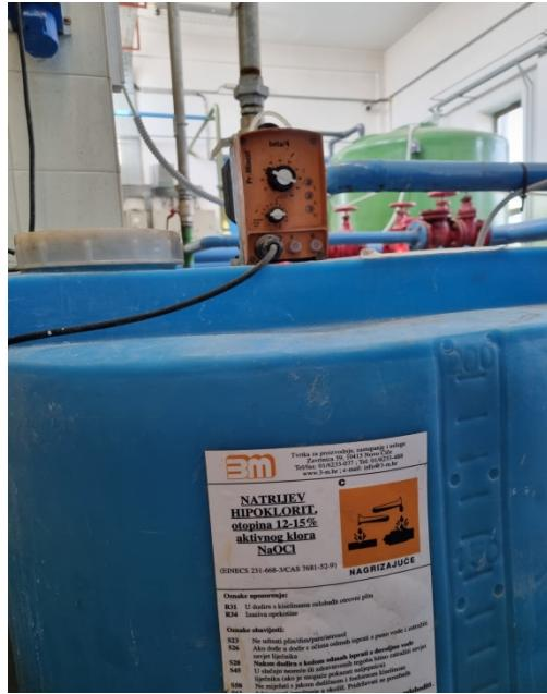
Slika 5. Uređaj za dezinfekciju natrijevim hipokloritom
