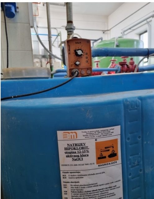
Slika 5. Uređaj za dezinfekciju natrijevim hipokloritom
