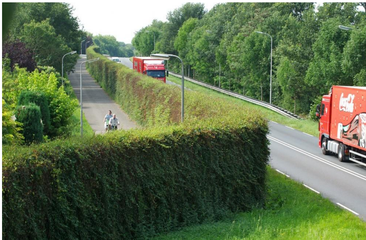
Slika 13 Zaštita od buke biljnim nasadom
