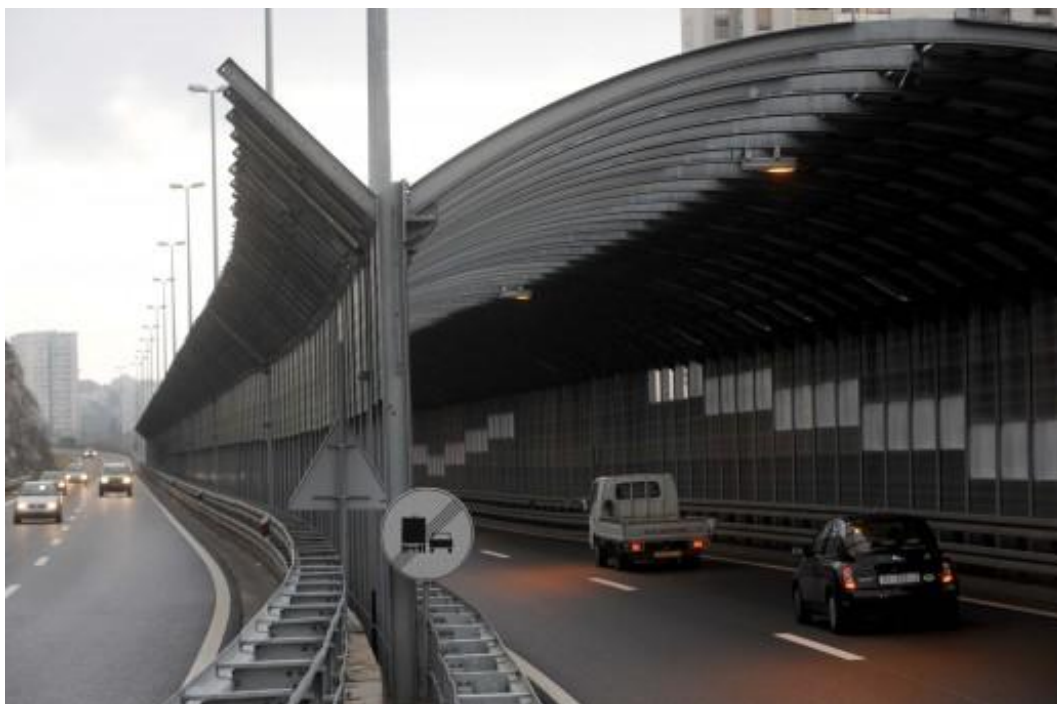
Slika 24 Solarna elektrana na riječkoj obilaznici ujedno i zid za zaštitu od buke
