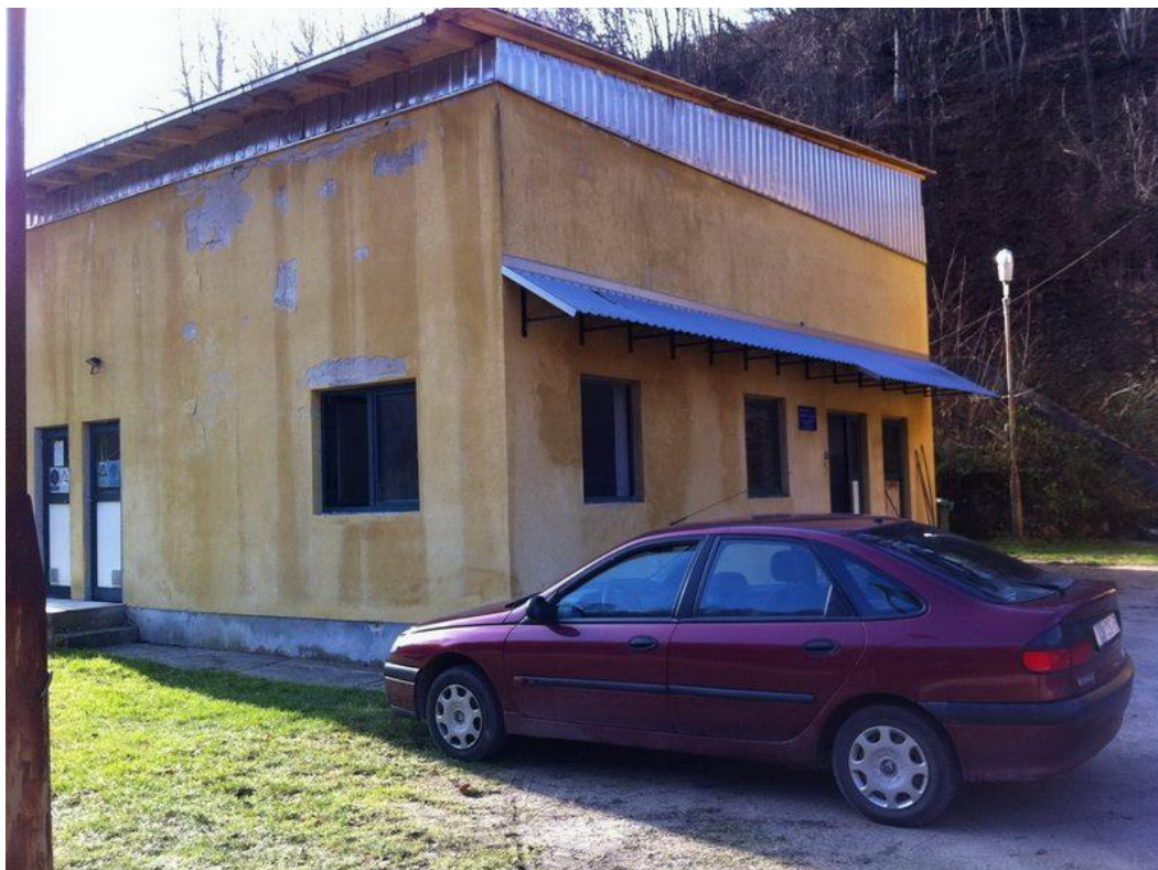
Slika 1: Crpna stanica izvana
