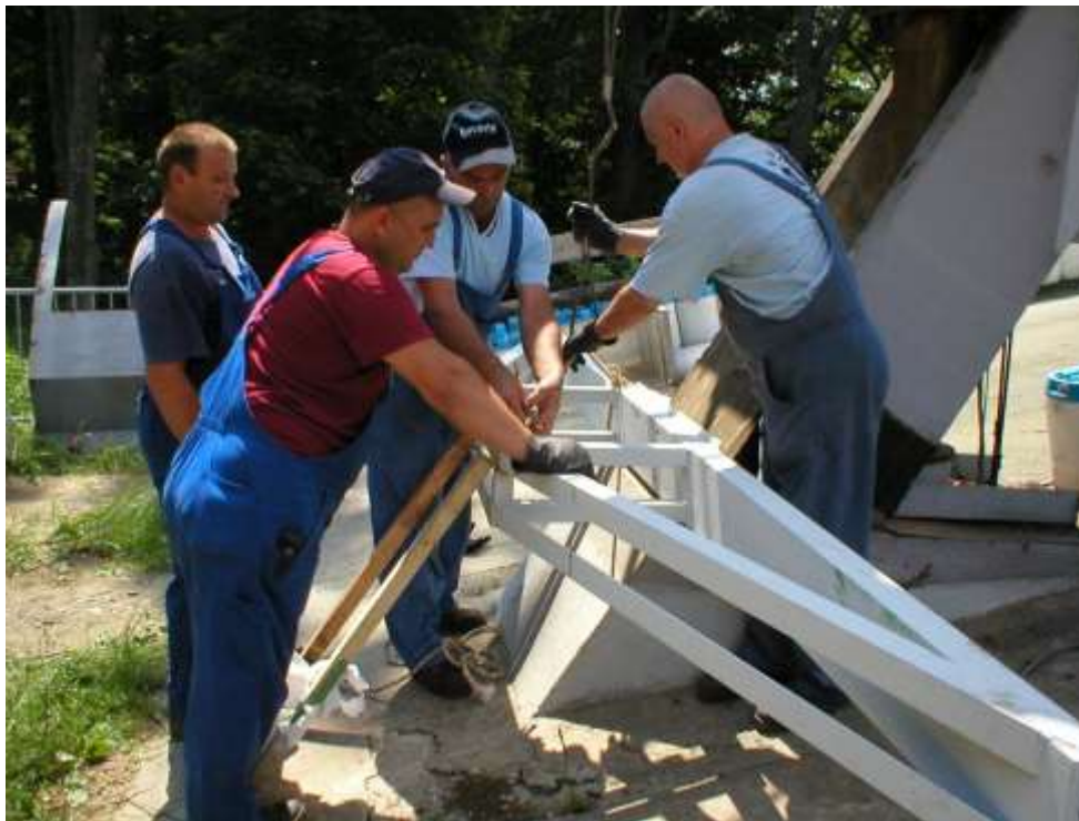
Slika 24 Naprava za preuzimanje nosivog užeta
