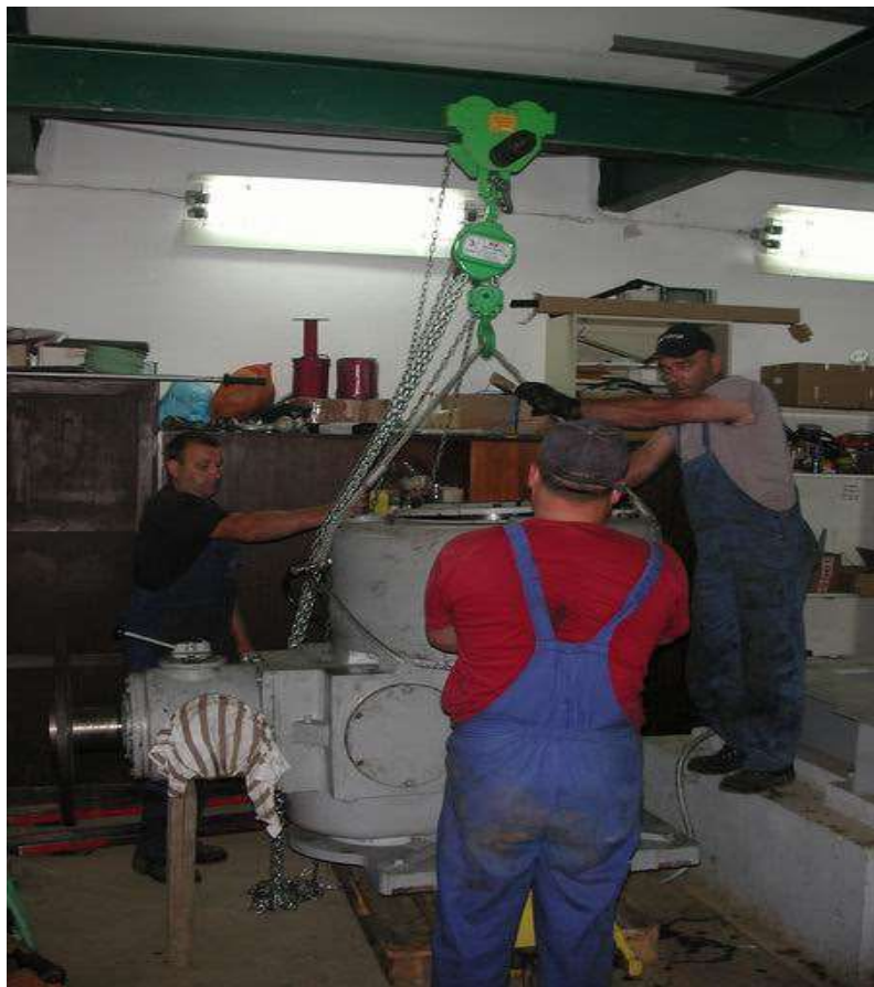
Slika 42 Demontažni postupak u podzemnoj strojarnici (2)
