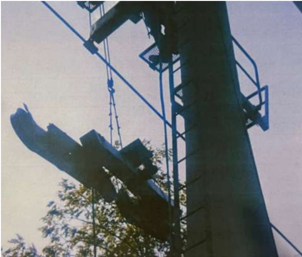
Slika 49 Demontaža baterijskog sklopa (3)
