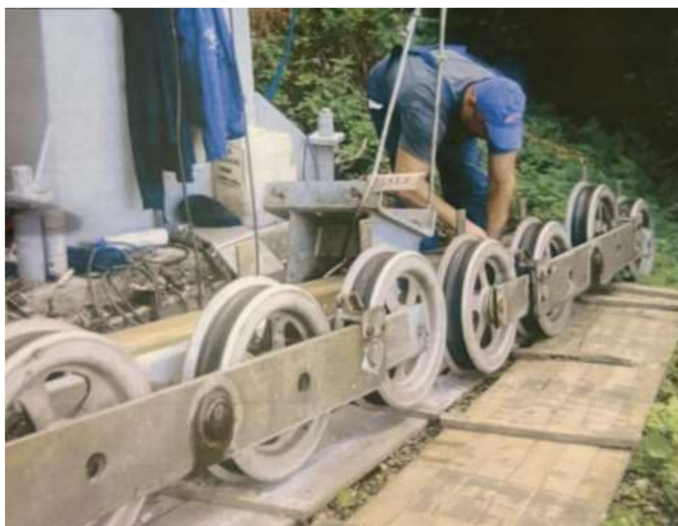
Slika 50 Demontirani baterijski sklop
