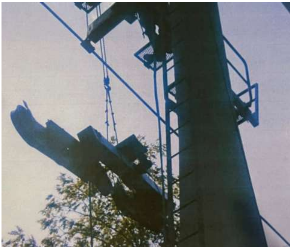
Slika 49 Demontaža baterijskog sklopa (3)
