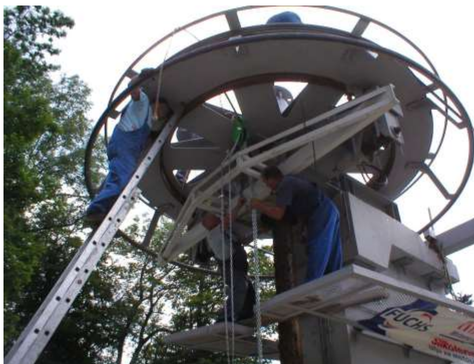
Slika 28 Montaža naprave za preuzimanje užeta (4)
