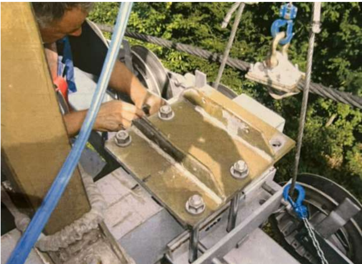
Slika 48 Demontaža baterijskog sklopa (2)
