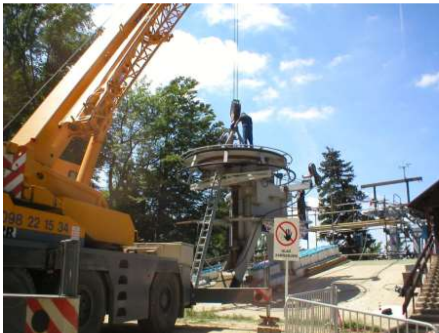
Slika 36. Skidanje kape pogonskog kotača
