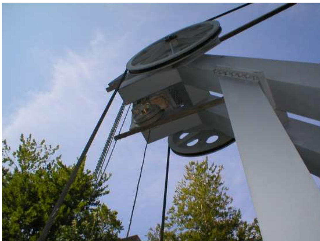
Slika 20 Montaža naprave za podizanje protuutega (2)
