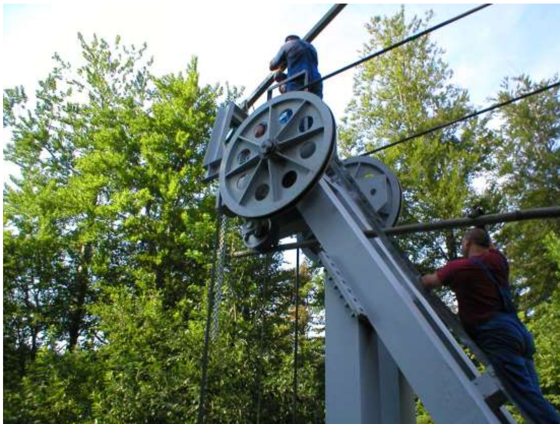
Slika 19 Montaža naprave za podizanje protuutega (1)
