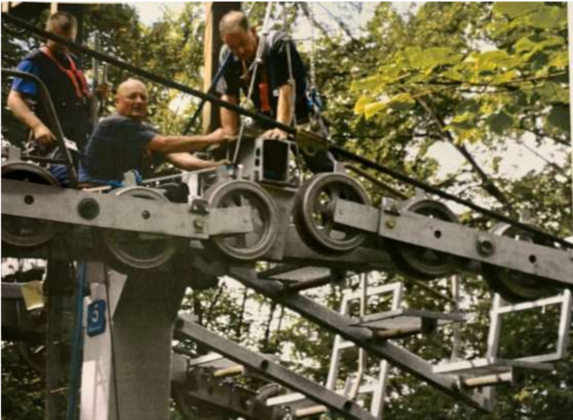
Slika 47 Demontaža baterijskog sklopa (1)
