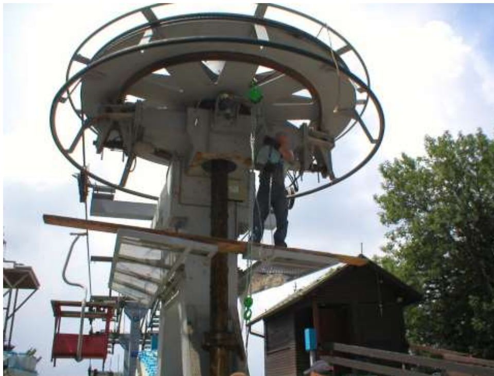
Slika 26 Montaža naprave za preuzimanje užeta (2)
