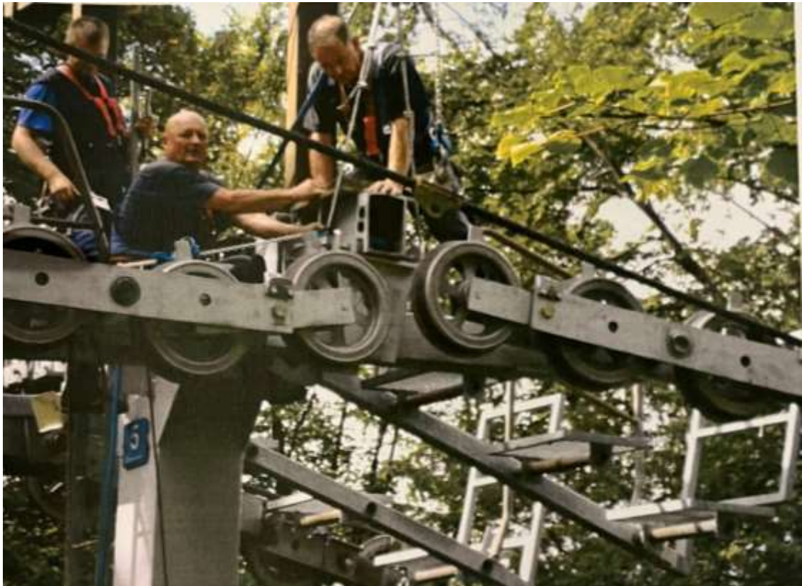
Slika 47 Demontaža baterijskog sklopa (1)
