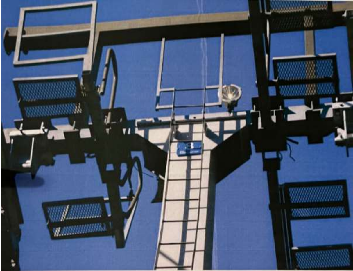
Slika 51 Stup oslobođen od baterijskih sklopova
