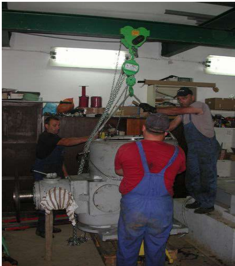
Slika 42 Demontažni postupak u podzemnoj strojarnici (2)
