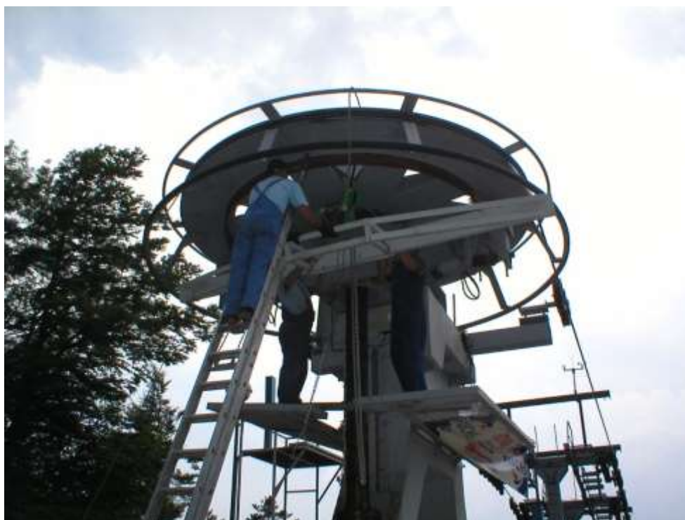
Slika 25 Montaža naprave za preuzimanje užeta (1)
