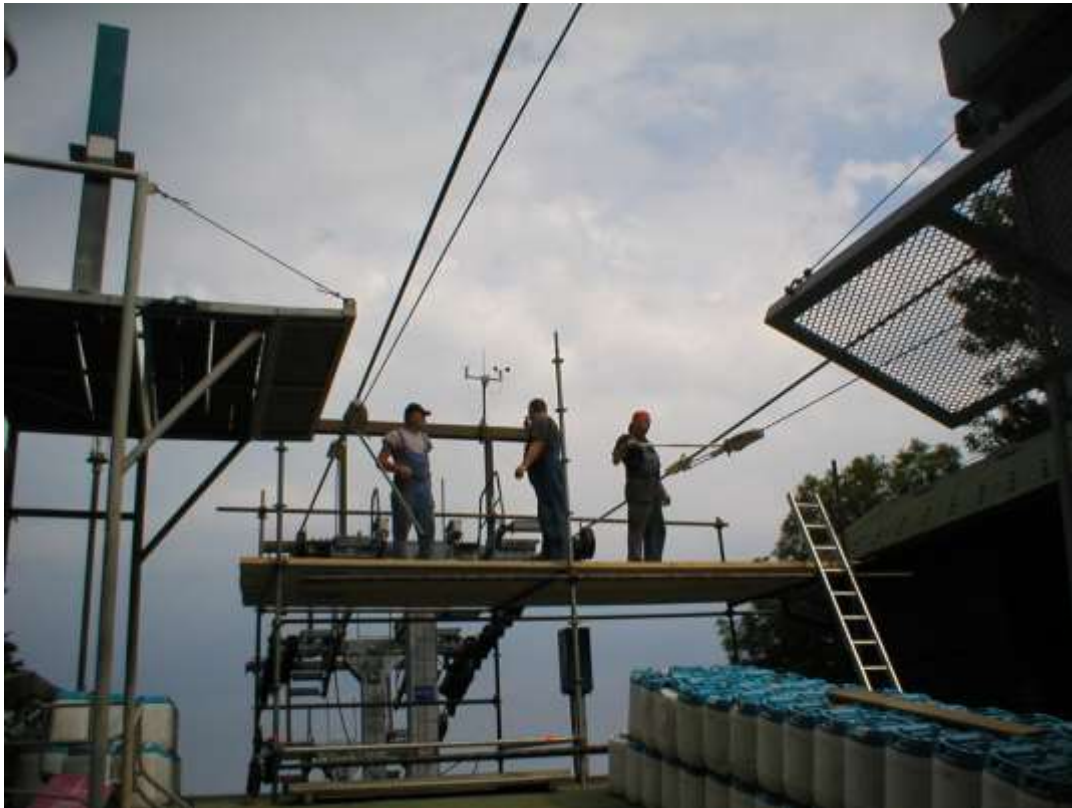
Slika 32 Montaža dvodjelne naprave za potezanje (2)
