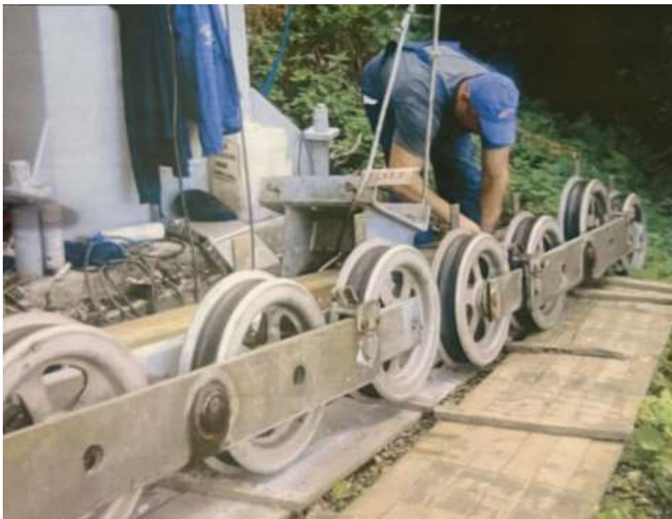
Slika 50 Demontirani baterijski sklop
