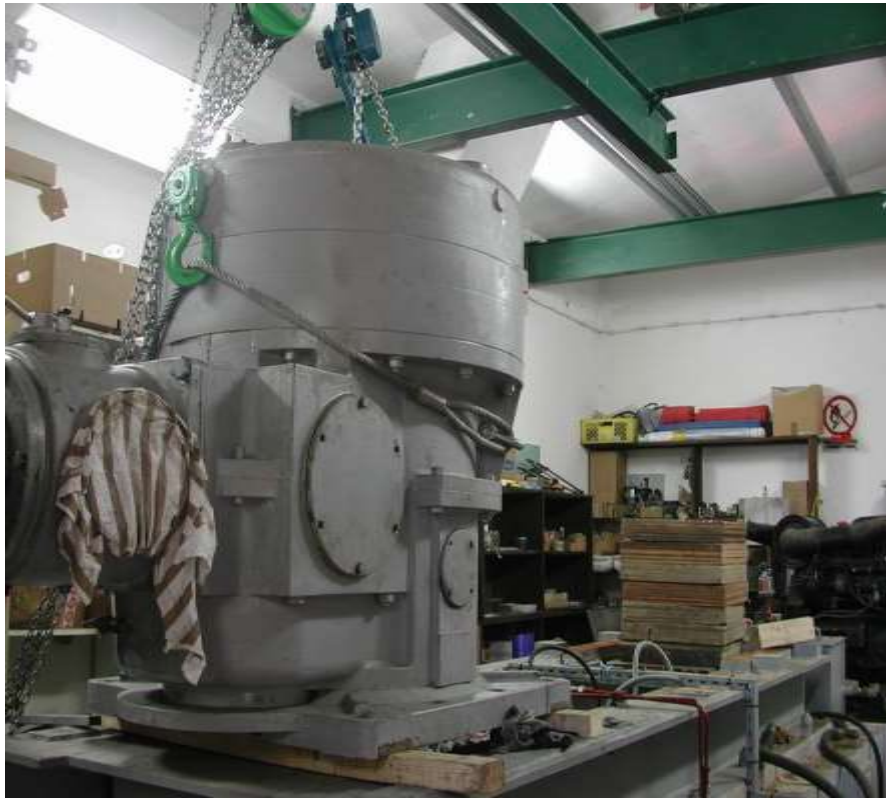
Slika 41 Demontažni postupak u podzemnoj strojarnici (1)
