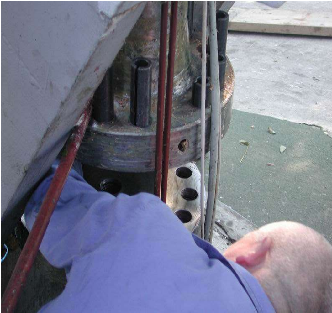
Slika 44 Demontaža dvodijelnog vratila
