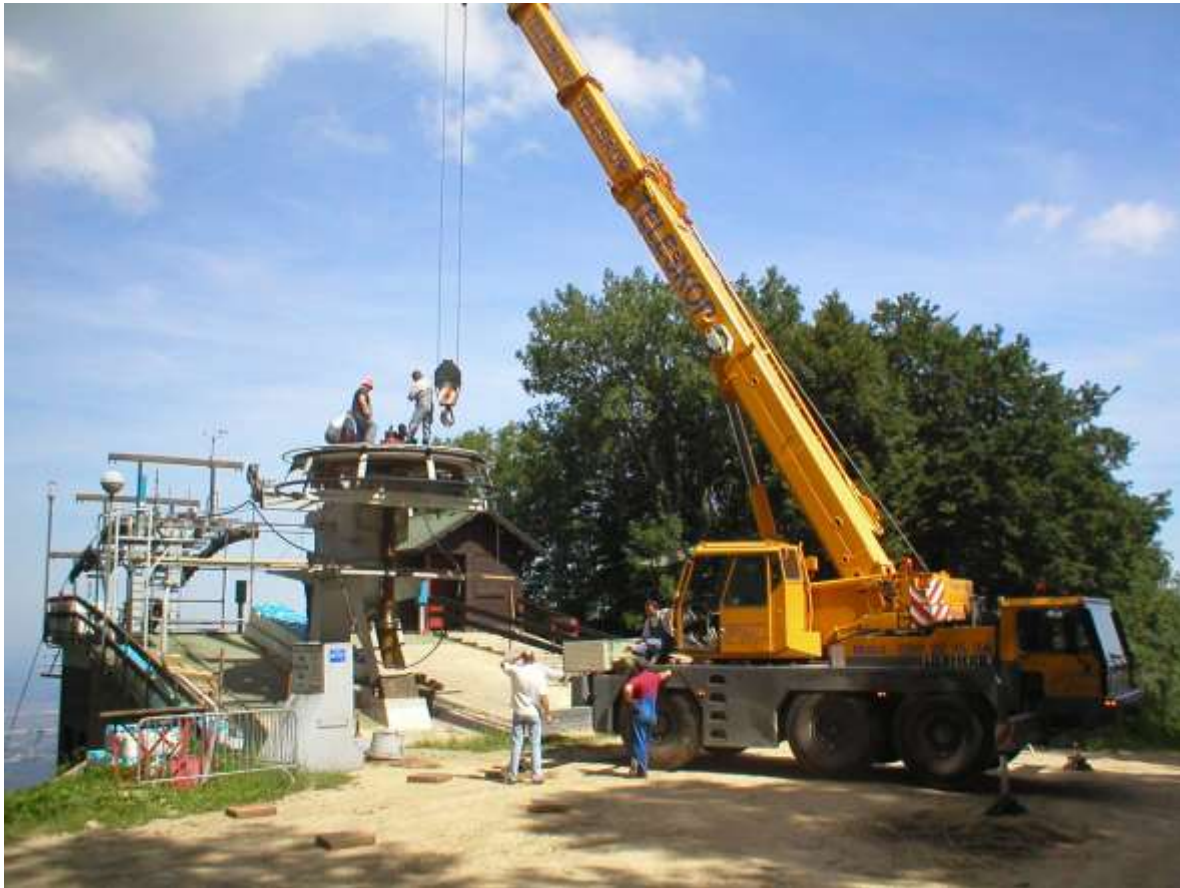
Slika 40 Podizanje dvodijelnog vratila (4)
