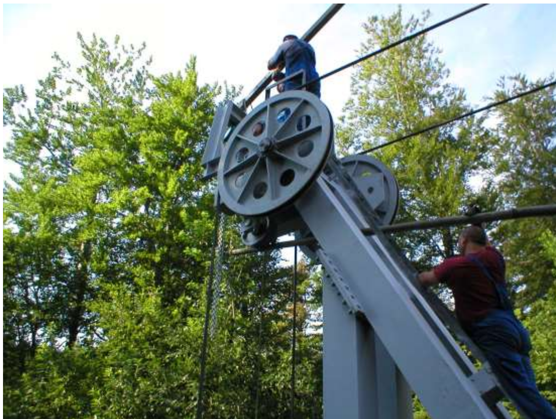
Slika 19 Montaža naprave za podizanje protuutega (1)
