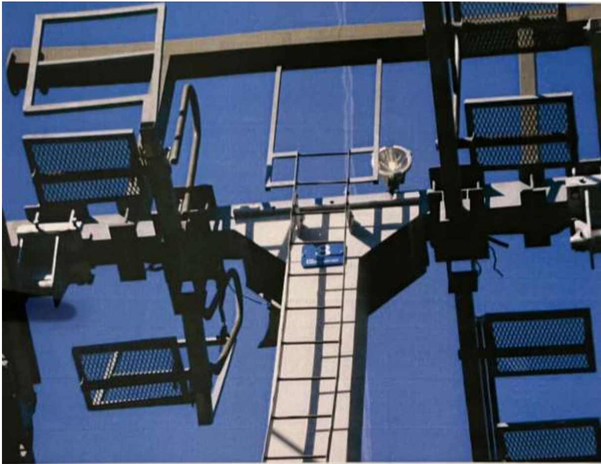
Slika 51 Stup oslobođen od baterijskih sklopova
