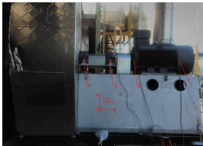
Slika 36. Slika mjernih mjesta ventilatorskih sistema ; Izvorno autor
