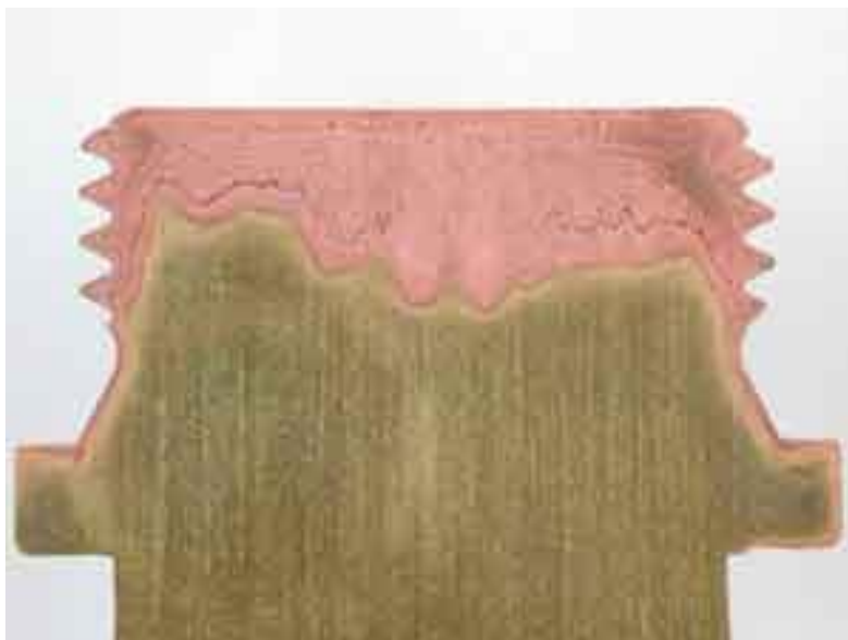
Slika 10. Selektivna korozija – decinkacija [21]
