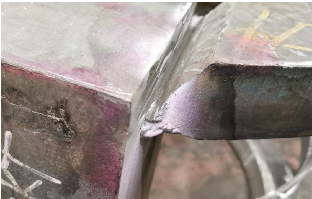
Slika 46. Izgled spoja nakon penetrantskog ispitivanja i brušenja
