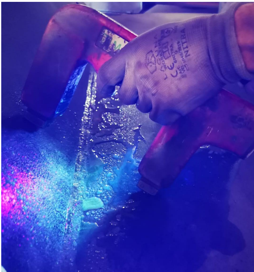
Slika 64. Magnetska kontrola zavarenih spojeva na zapornom tijelu
