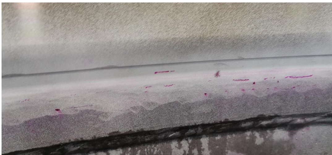
Slika 59. Neprihvatljive indikacije na zavarenom spoju „prstena“ i „poluprstena“
