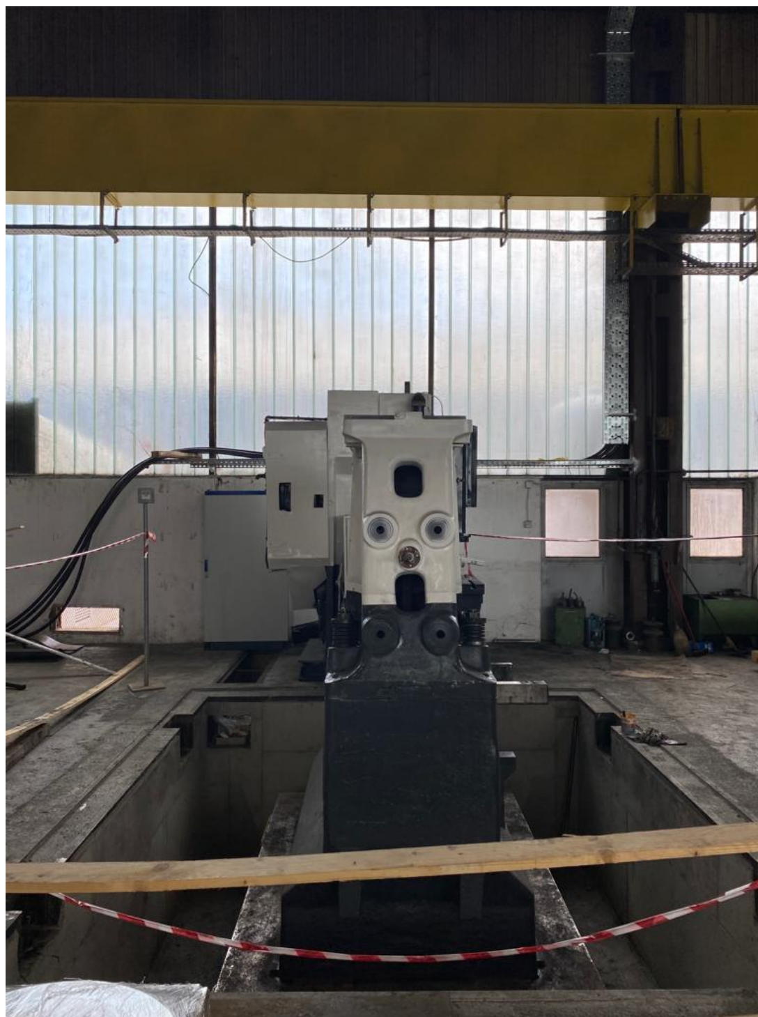
Slika 9 Osiguranje mjesta ugradnje
