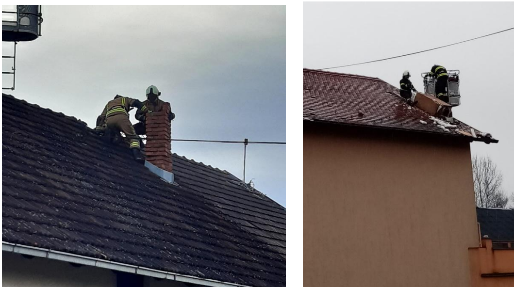
Slika 35. Skidanje opasnih dimnjaka [17]
