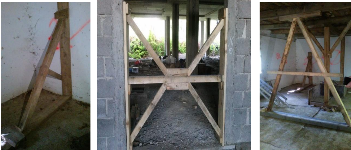
Slika 10. Primjeri izrađenih podupora [17]
