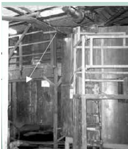
Slika 13: WWT pročišćivač otpadnih voda [12].
