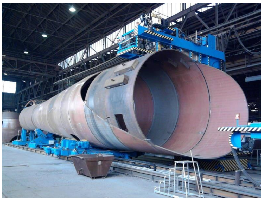
Slika 24 Postrojenje za zavarivanje cijevi [27]
