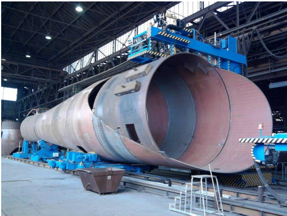
Slika 24 Postrojenje za zavarivanje cijevi [27]
