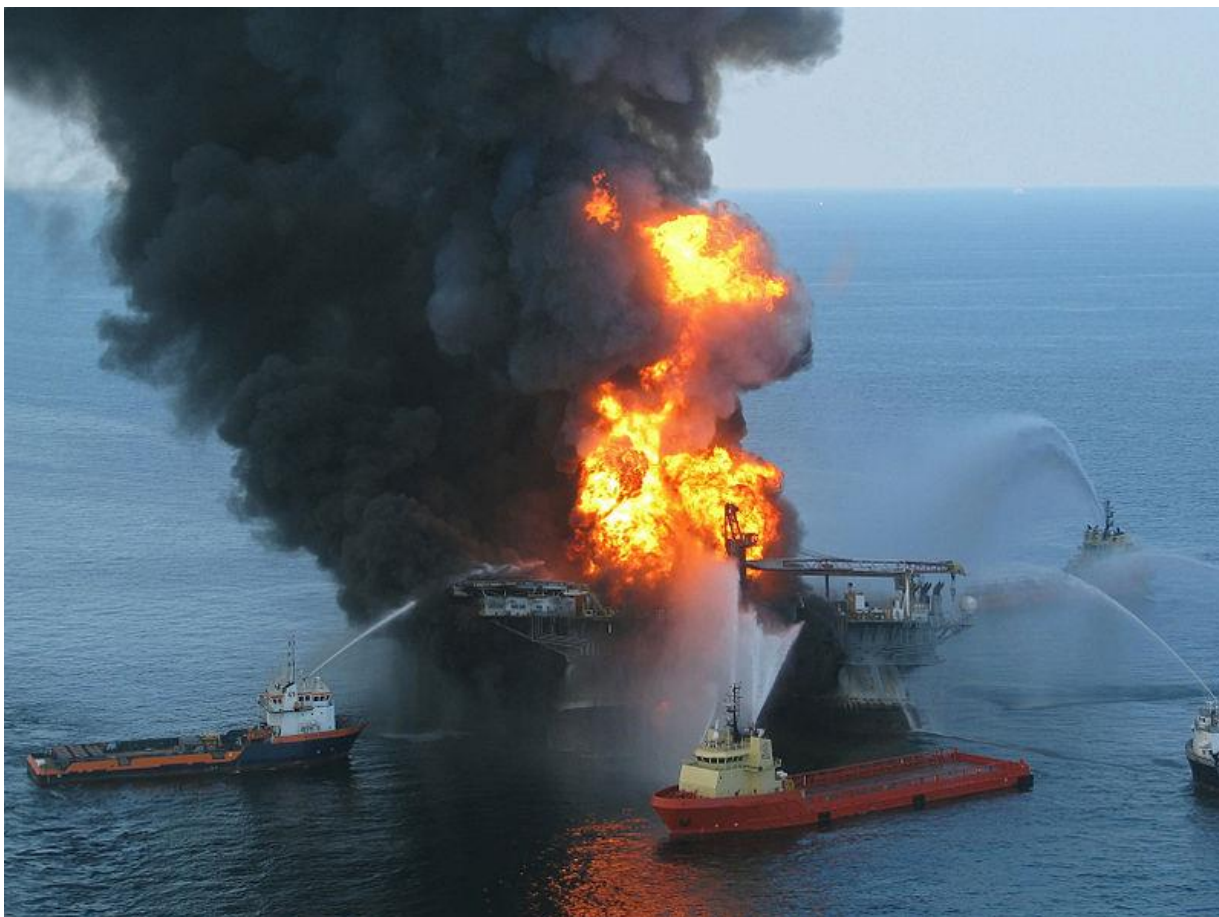
Slika 4: Naftna platforma Deepwater Horizon nakon eksplozije
